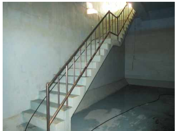
〔배수지 2호지 : 난간 상태양호〕
