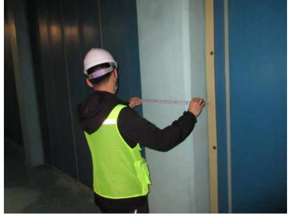
(배수지 내부 : 부재규격조사)
