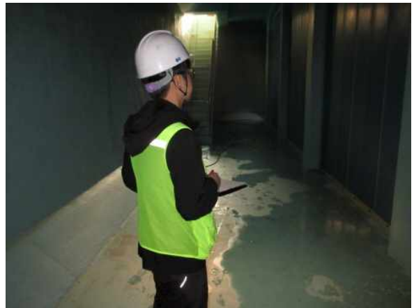
(배수지 내부 : 조사 전경(2))
