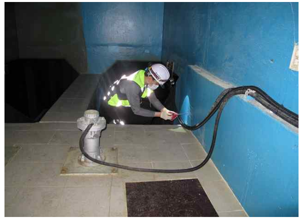
(콘크리트 탄산화 깊이 측정)
