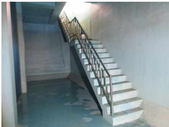
〔배수지 1호지 : 난간 상태양호〕
