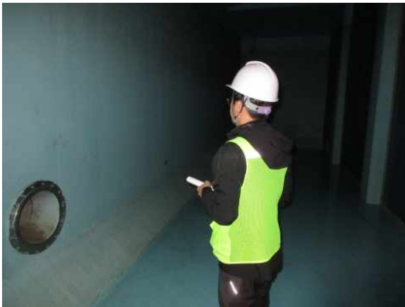
〔배수지 내부 : 조사 전경(1)〕
